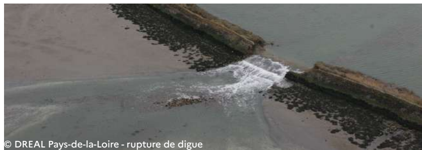
© DREAL Pays-de-la-Loire - rupture de digue
