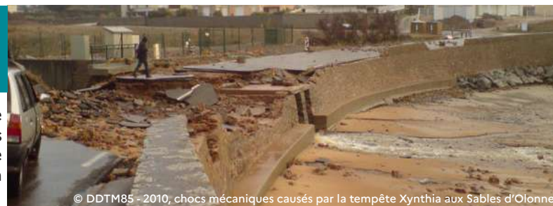
© DDTM85 - 2010, chocs mécaniques causés par la tempête Xynthia aux Sables d'Olonne
